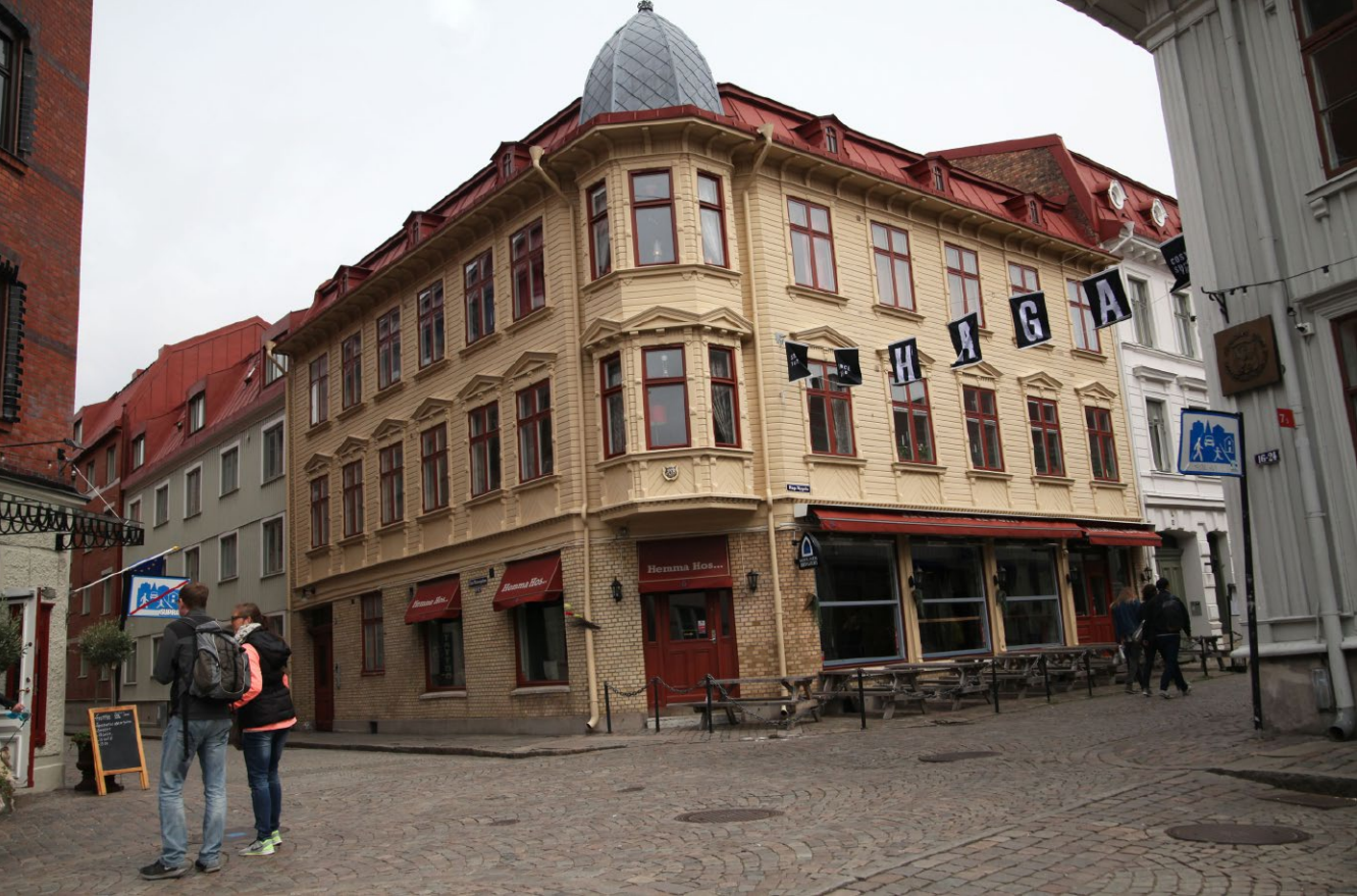
Kuva 3. Maaherrantalo yleisty 1800-luvun loppupuolella. Talon pohjakerros oli kiveä ja kaksi kerrosta puuta. Kuvassa yksi Hagan peruskorjatuista taloista. Kuva: Jukka Tuominen.
