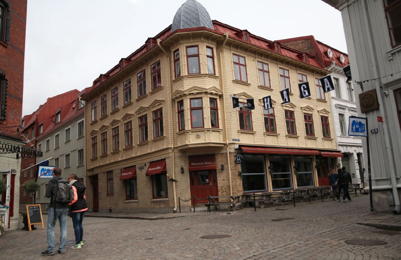
Kuva 13. Haga on kokenut muodonmuutoksen, kun vanhoja maaherrantaloja on kunnostettu. Kuva Jukka Tuominen.
