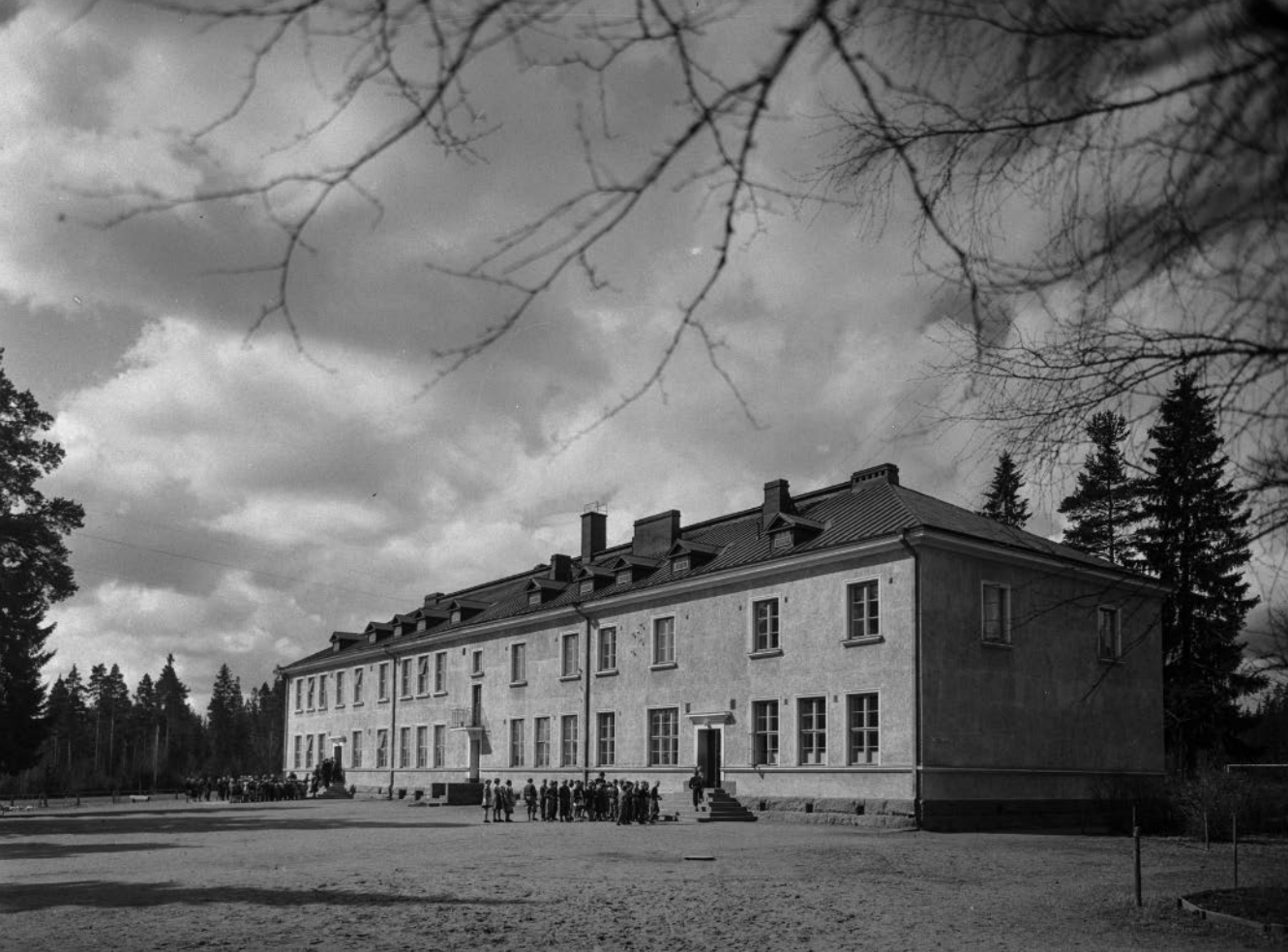
Lamminpään koulun ensimmäinen osa on vuodelta 1929. Toinen samankokoinen osa valmistui 1935. Vuokrasopimus inkeriläisiä varten allekirjoitettiin 4.5.1943. Tiloja saatiin käyttöön 700 m 2 ja ne otti vastaan korpraali Unto Nieminen. Koulu luovutettiin takaisin runsaan kolmen kuukauden kuluttua 13.8.1943 ja luovutuspöytäkirjan allekirjoitti alikersantti Unto Nieminen. Kuva: Veikko Kanninen 1955, Vapriikin kuva-arkisto.
